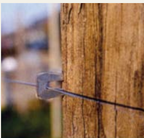
Cambretta arpionata di acciaio galvanizzato
