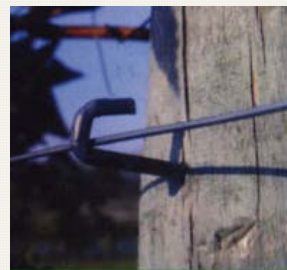
Chiodo distanziatore di acciaio zinco alluminio
